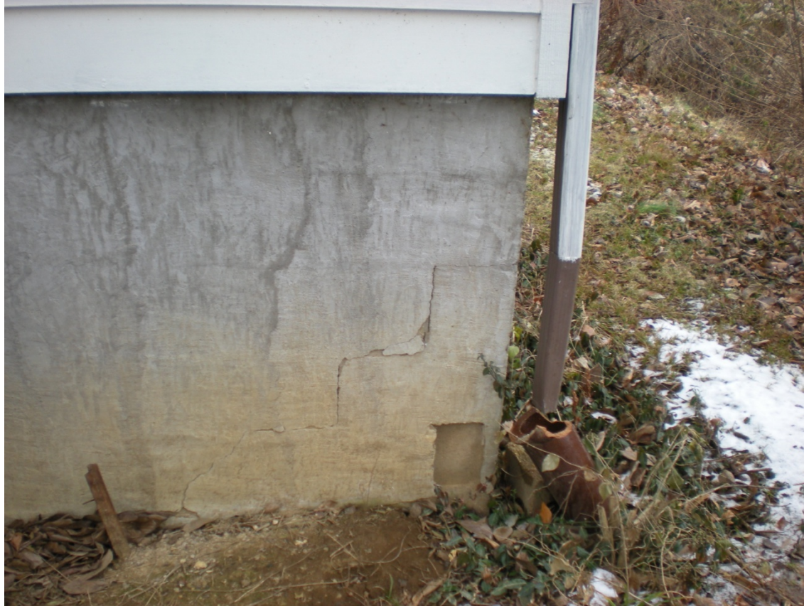
混凝土砌块墙 台阶状裂缝 Step Crack in CMU wall
